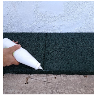
Repetir operación para el resto de losetas.
